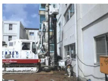
②杭打設：長さ8mの鋼管杭
